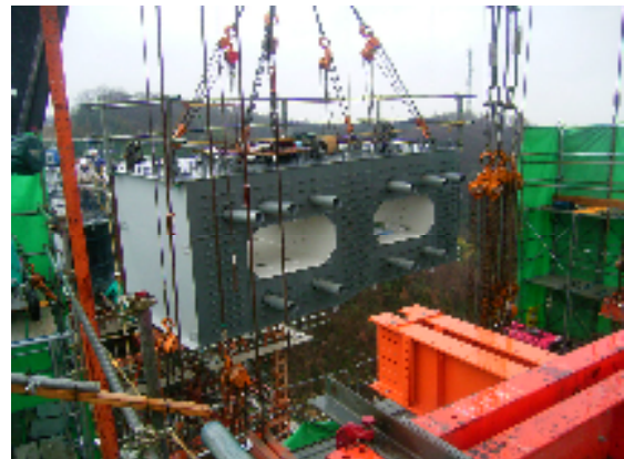
写真-1 接合部架設状況
