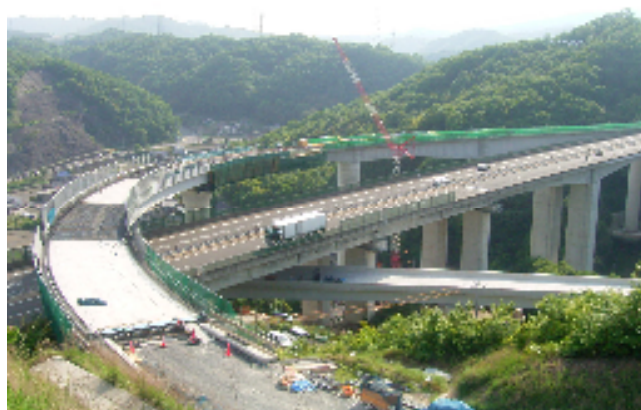
写真-2 現場状況写真 (H21年5月撮影)
