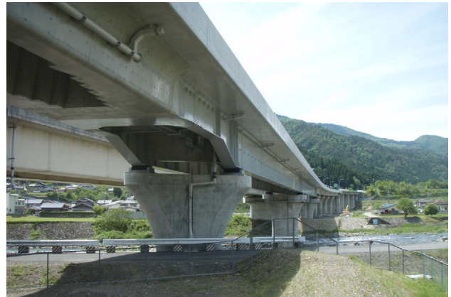
写真 - 1 大和橋全景
