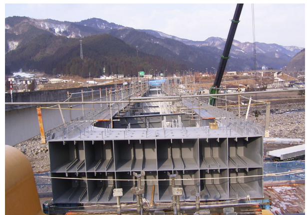
写真 - 2 接合桁架設後
