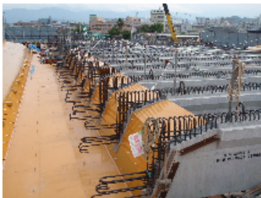
写真-1 横リブ設置状況
