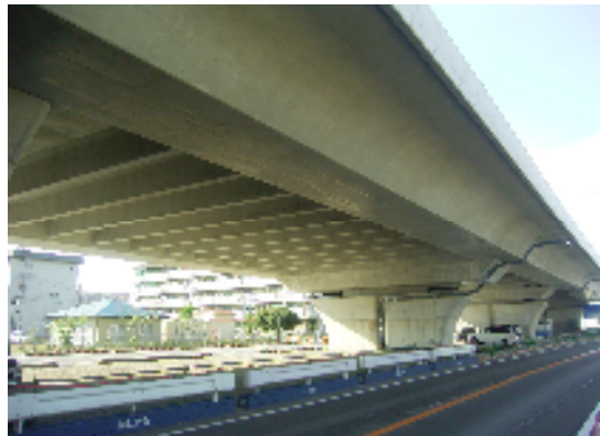
写真-2 完成写真全景
