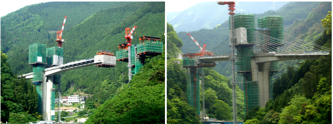
写真-1 施工状況
