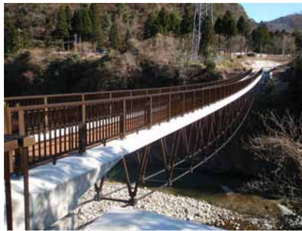
写真- 2 完成写真
