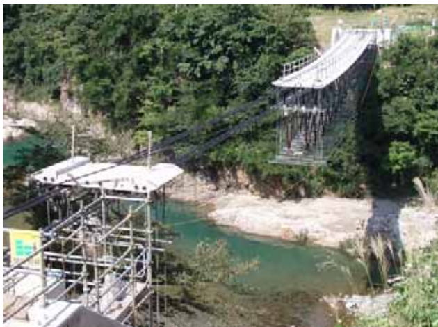
写真- 1 プレキャスト版の架設
