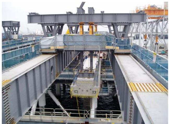
写真-2 架設ガーダーによる PCa 受梁の架設
