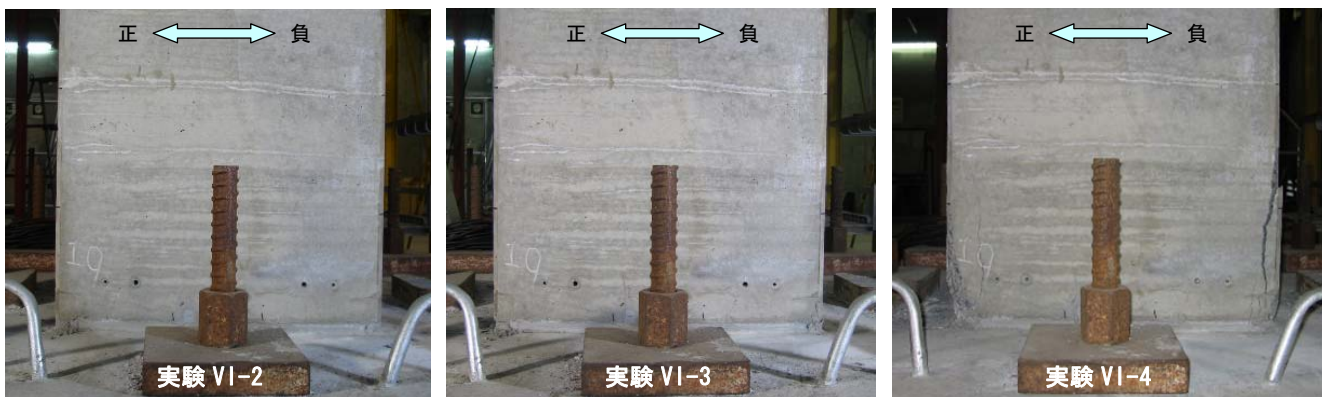
写真-1 各シリーズ加力終了時 1階柱脚損傷状況
