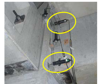
写真-1 変位計設置状況
