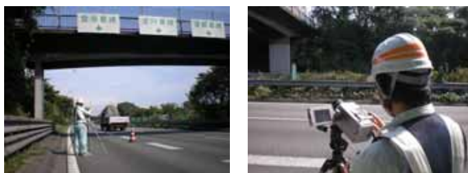
写真 2 跨道橋撮影状況(車線規制内)
