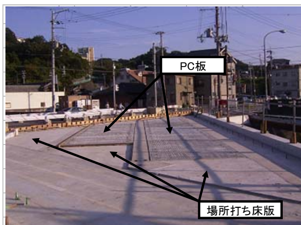
写真 - 4 PC板設置完了
