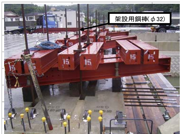
写真 - 2 枝桁支持架台
