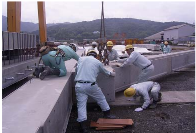
写真-1 仮組立状況
