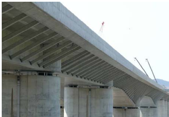
写真-7 拡幅床版施工完了
