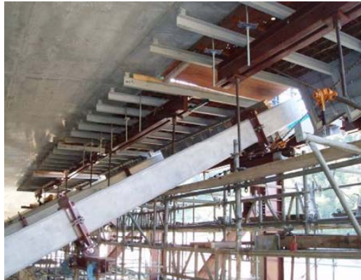
写真-5 ストラットセット完了
