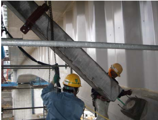
写真-4 ストラットセット状況
