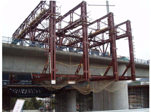
写真-2 移動作業車組立状況
