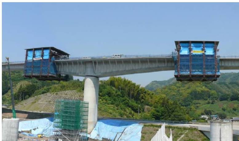
写真-1 拡幅床版施工状況
