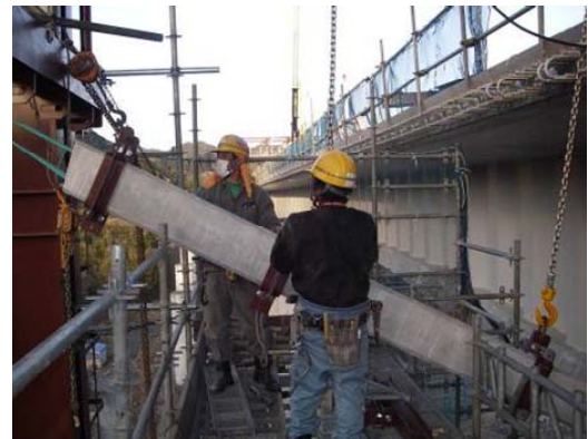
写真-3 ストラット仮置き状況
