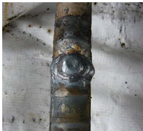
写真-6 エンクローズ溶接外観
