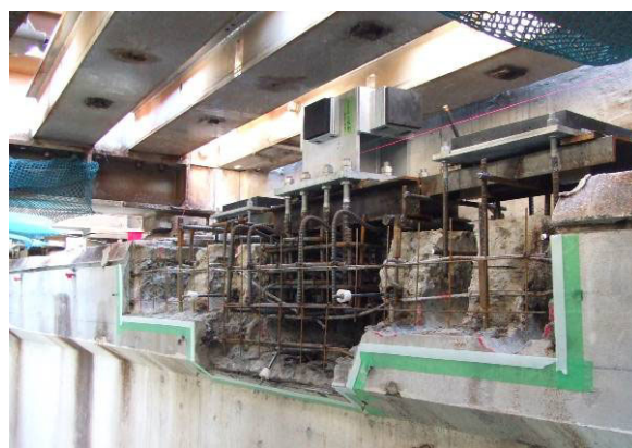
写真-3 支承部の施工状況
