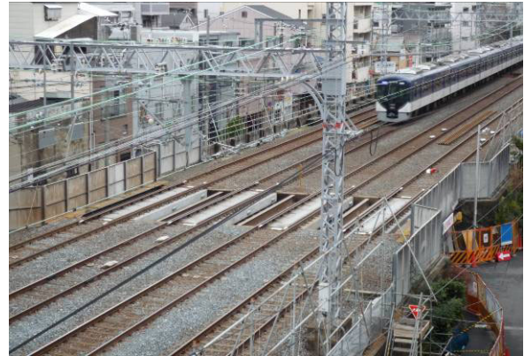
写真-1 榎並第3架道橋 (施工完了後)
