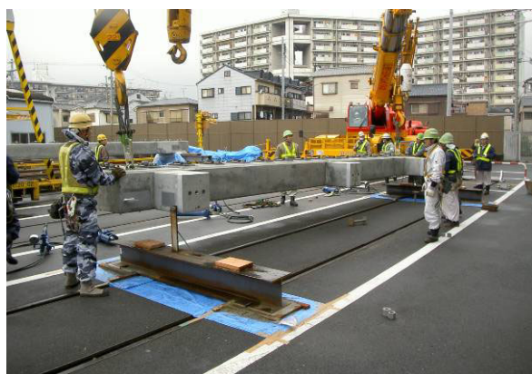
写真-2 軌道桁の架設試験状況
