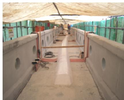
写真-8 給熱養生状況
