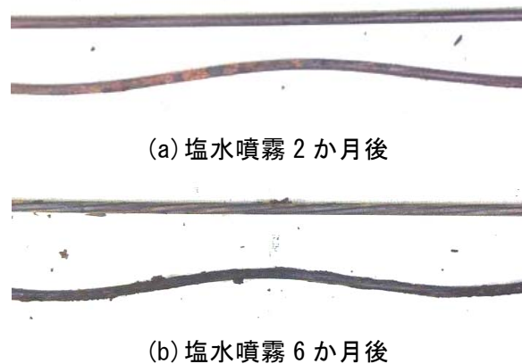
図-3 塩水噴霧終了後の素線の外観状況 (上: 芯線, 下: 側線の1本)
