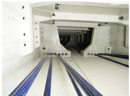
写真-2 桁内外ケーブル配置
