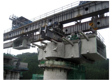
写真-4 セグメント架設状況
