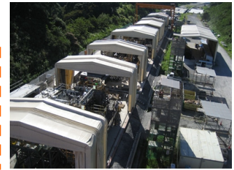
写真-3 製作ヤード全景
