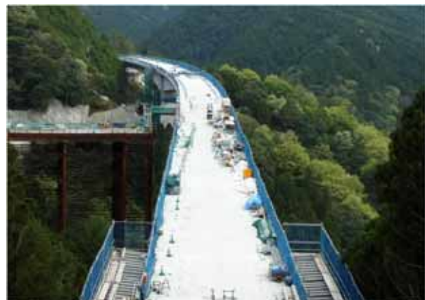
写真 - 1 施工状況
