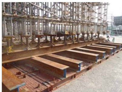
写真-3 覆工板+H形鋼併用の直接基礎
