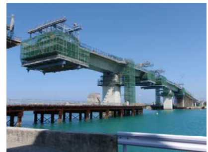
写真-1 大型移動作業車による張出架設施工状況
