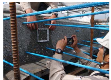
写真-2 表面処理後の撮影状況
