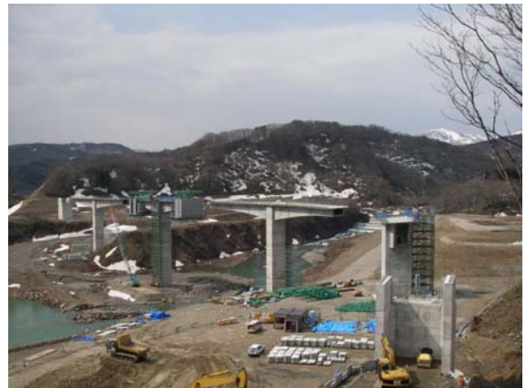
写真-1 施工状況
