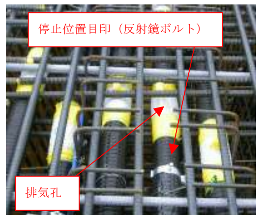
写真-2 最高部シース組立て状況
