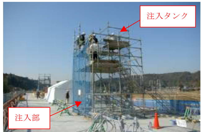
写真-1 グラウト注入部全景
