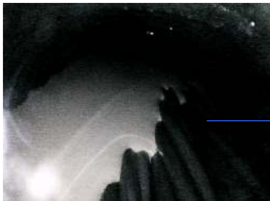
写真-7 シース内充填状況（傾斜部充填中）
