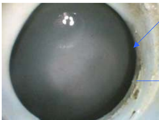
写真-9 シース内充填状況（最高部充填中）
