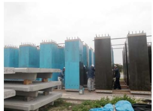
写真-4 PCa部材防食塗装施工
