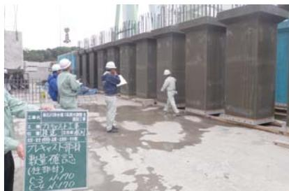
写真-1 PCa柱製作状況
