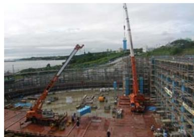
写真-2 PCa部材組立状況
