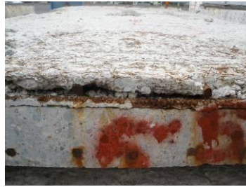
写真-4 損傷したRC床版 (下は拡大写真)
