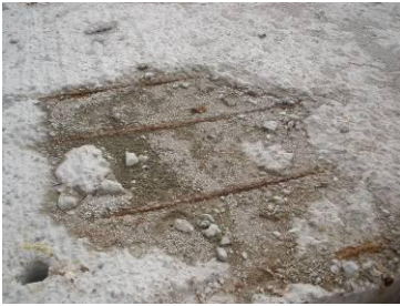
写真-4 損傷したRC床版 (下は拡大写真)
