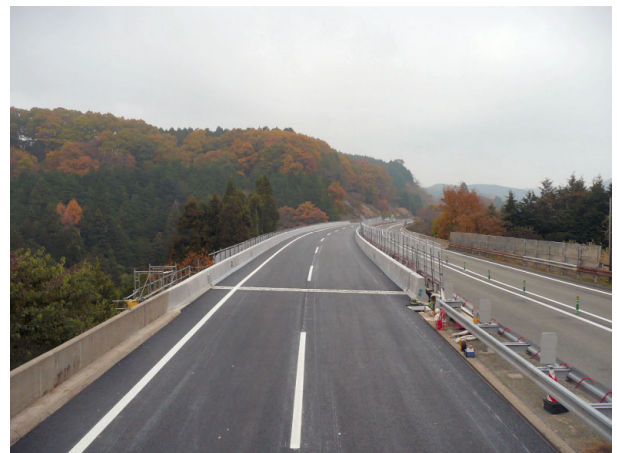
写真-7 完成写真
