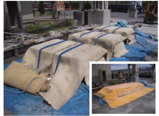
写真-2 養生状況
