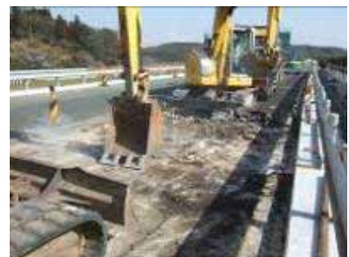
写真-1 バックホウによる 舗装除去作業
