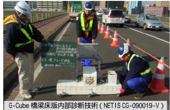
写真-9 3次元レーダー調査(複数のセンサーを使用)
