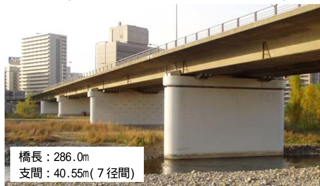
写真-1 南 7 条橋全景 (上流側右岸から見る)
