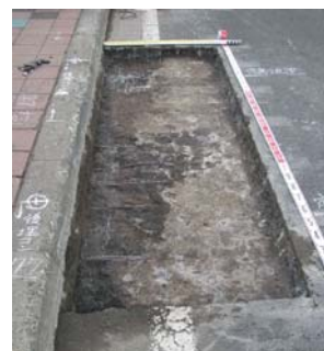
写真-10 舗装除去後の床版上面目視確認
