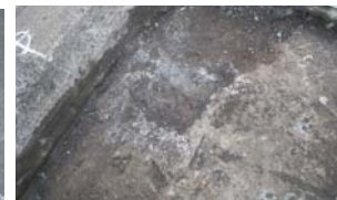
写真-11 後埋め部
