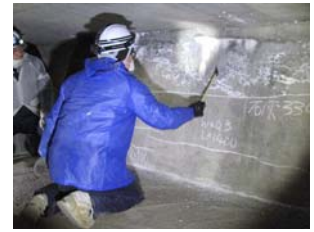
写真-3 近接目視調査(内空高1,360mm)
