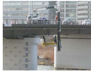
写真-2 河川部の橋梁点検車での外観目視調査
