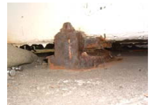
写真-2 支承の状況
