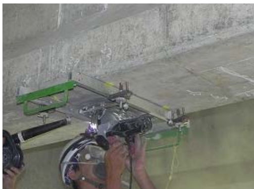
写真-3 スリット切削状況
