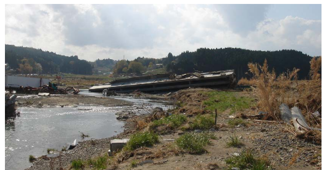
写真-7 上部構造断面Bの流出桁
