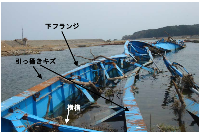
写真-1 主桁（左岸3径間分）
