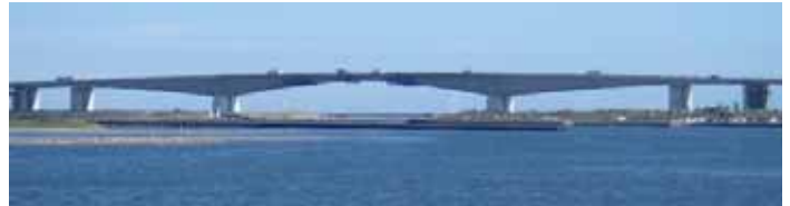
写真-1 浜名大橋全景
