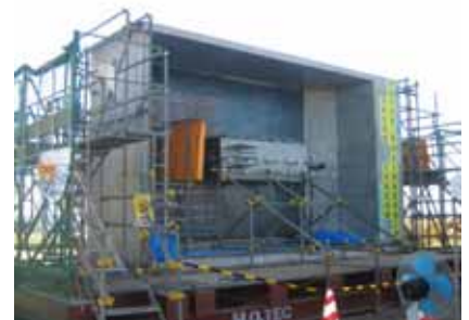
写真-2 試験体全景
