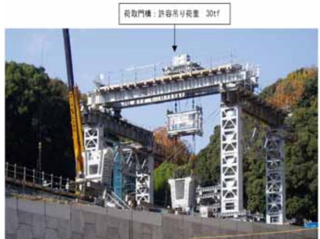
写真-3 A2 ヤード入り口に荷取り門構設置 (30tf 吊)
