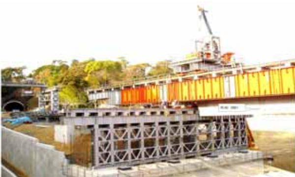
写真-7 架設桁と共にPC桁横移動（抱込み）
