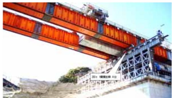
写真-8 200t 横移動台車（各架設桁下に2台）
