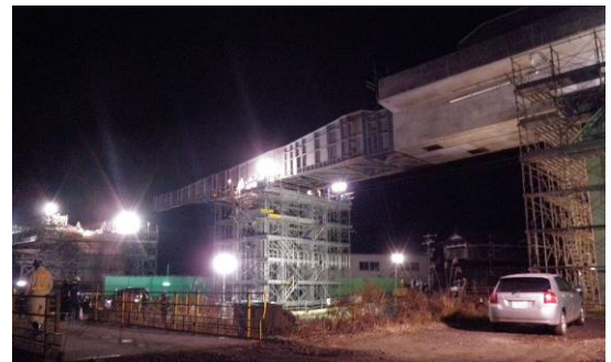
写真-5 押し出し施工状況
