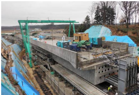
写真-5 押し出し施工状況
