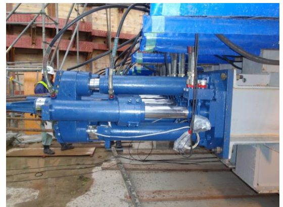
写真-2 ダブルツインジャッキ
