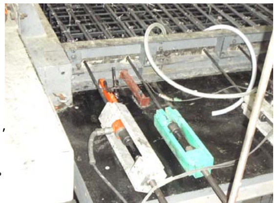
写真-5 変位計・ロードセル
