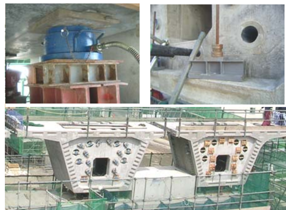
写真-7 横桁構築前の柱頭部セグメント (仮受けジャッキ・仮固定ストランド)
