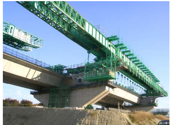
写真-6 ハンガータイプ架設機
