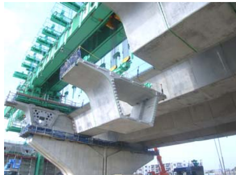
写真-2 セグメント架設状況
