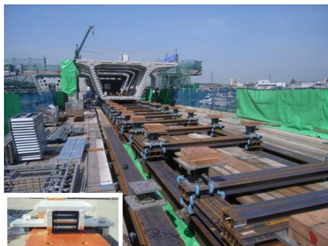
写真-9 固定支保工による架設
