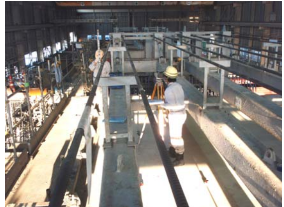
写真-3 デジタルレベルによる橋面測量
