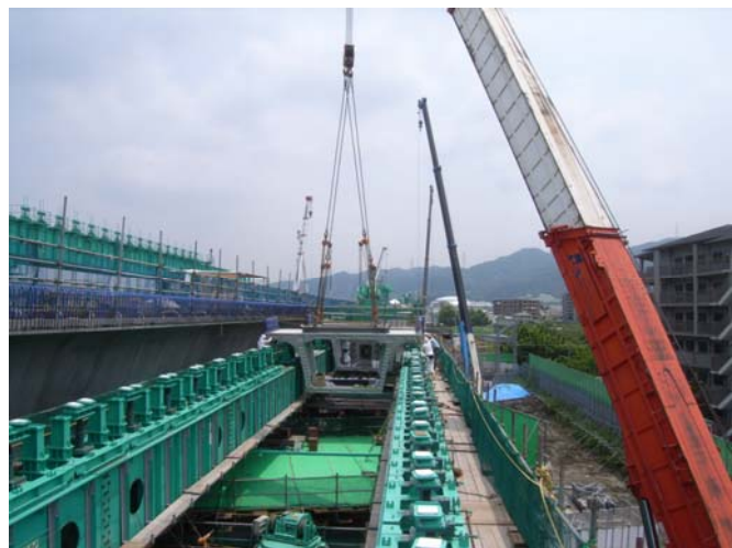
写真-8 サポートタイプ架設機
