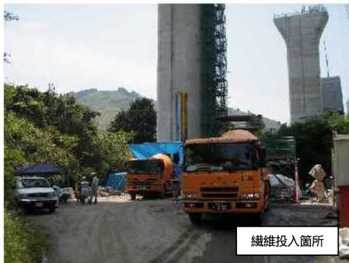
コンクリート打設全景
