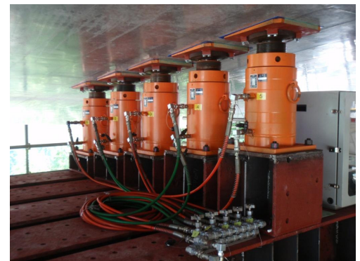
写真-2 ジャッキ設置状況
