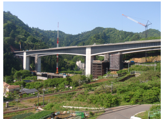
写真－1 現場全景
