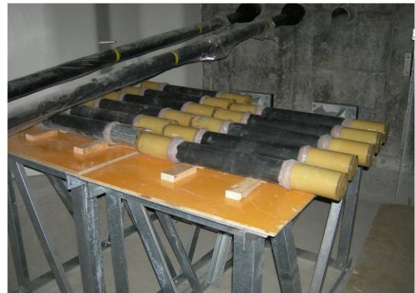
写真-4 劣化確認サンプル
