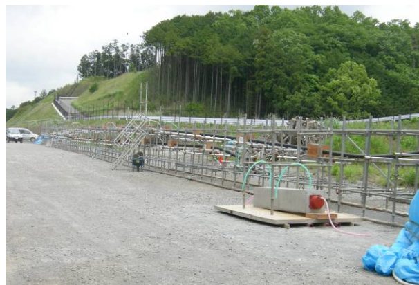
写真-6 グラウト注入試験状況
