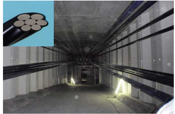
写真-3 エポキシ樹脂被覆PC鋼材
