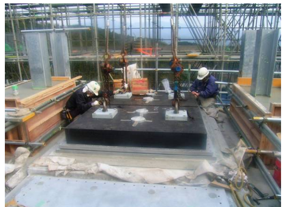
写真-2 超高減衰積層ゴム支承の設置
