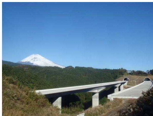
写真-7 谷津川橋全景
