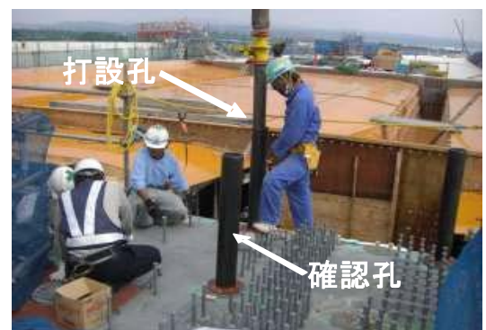
写真-2 コンクリート打込み状況
