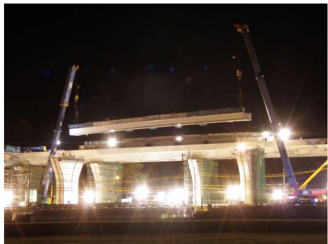
写真-1 大型クレーンによる相吊架設
