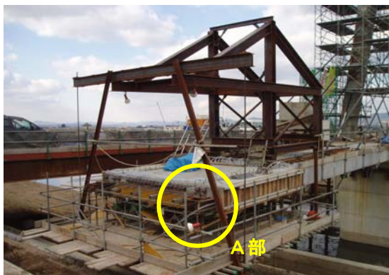
写真-1 内包鋼材を架設材に兼用した例
