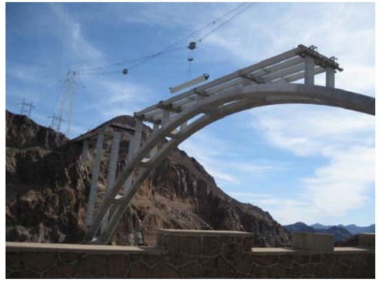
写真-6 鋼製ガーダー架設状況
