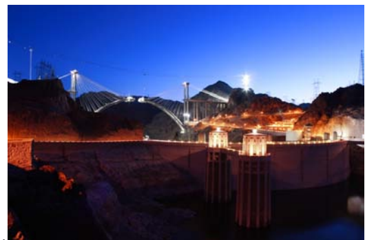
写真-1 施工中のコロラドリバー橋
