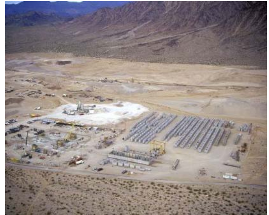
写真-3 プレキャストヤード全景
