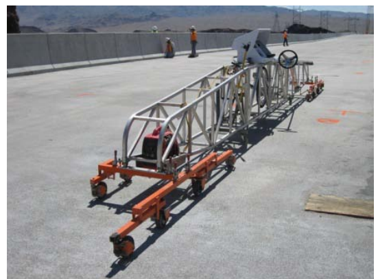
写真-9 橋面平坦性試験
