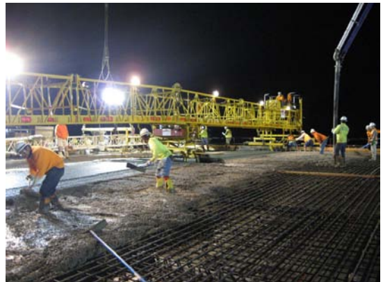
写真-8 床版コンクリート打設状況
