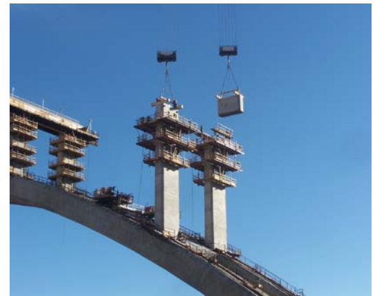
写真-4 セグメント架設状況
