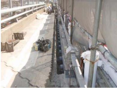
写真-6 中間定着工完了
