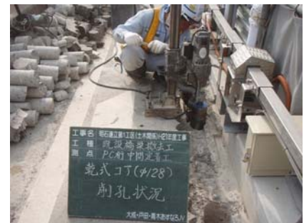
写真-3 間詰めコンのコア削孔
