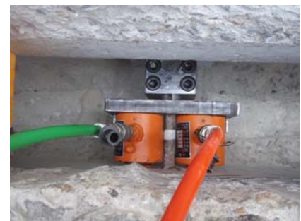
写真-4 定着具取付・ウェッジ圧入
