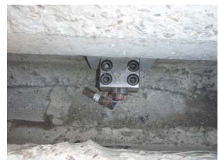
写真-5 横締め PC 鋼棒切断
