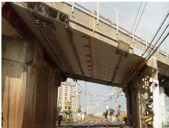
写真-1 PC橋の撤去施工前状況
