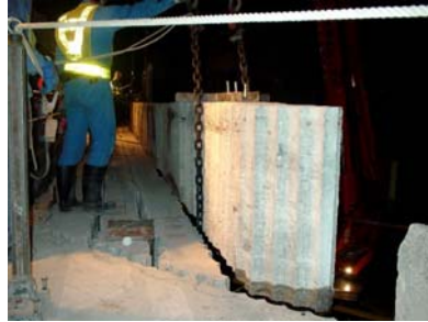
写真-7 PC桁撤去状況
