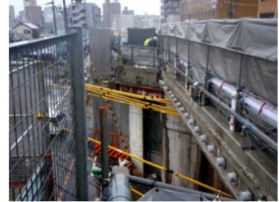
写真-8 拡幅部PC桁撤去完了
