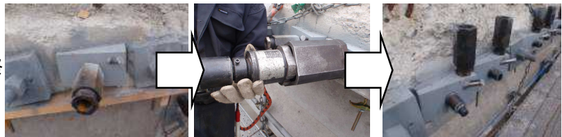
写真 - 6. NAPP ユニットのプレストレス導入状況
