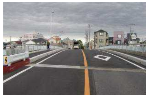
写真 - 9. 竣工後の現橋
