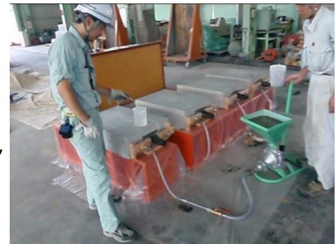
写真 - 2. モルタル注入試験状況
