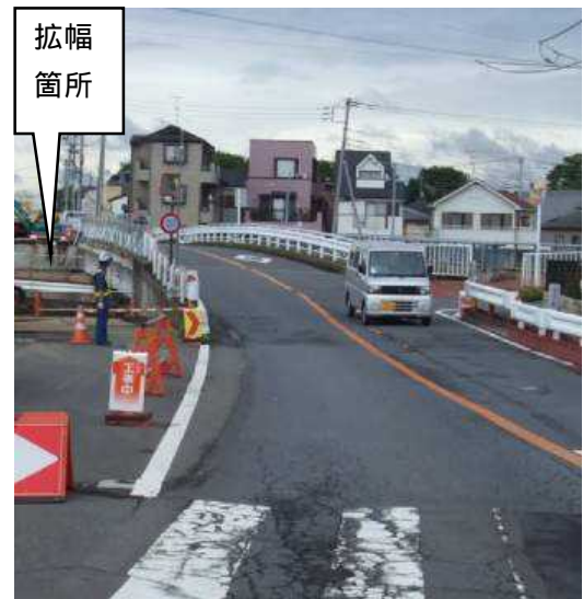
写真-1. 施工前の既設橋梁
