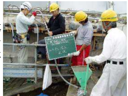
写真 - 5. モルタル注入状況
