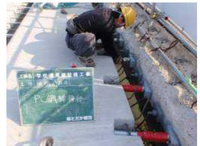
写真 - 6. NAPP ユニットのプレストレス導入状況
