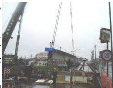
写真 - 7. 主桁架設状況
