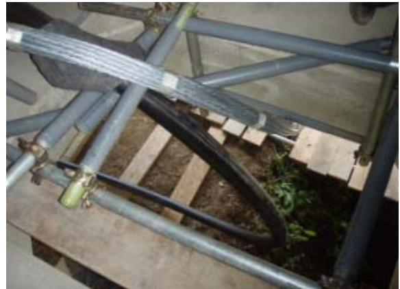
写真-4 下床版マンホールのPCケーブル挿入状況
