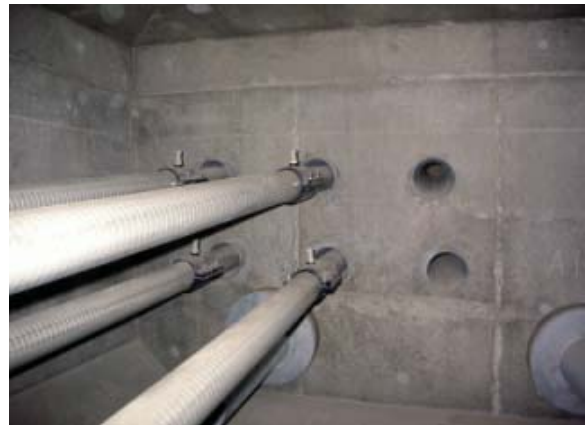
写真-2 箱桁内の状況
