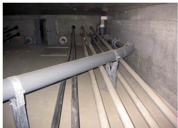
写真-3 箱桁内の状況
