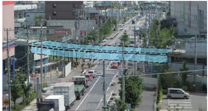
写真-1 現場状況
