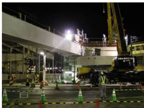
写真-3 主桁横取り
