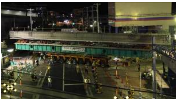
写真-2 主桁運搬
