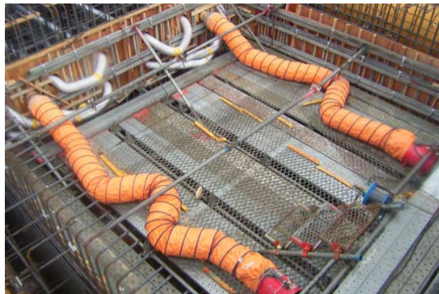
写真-1 クーリング機材配置状況
