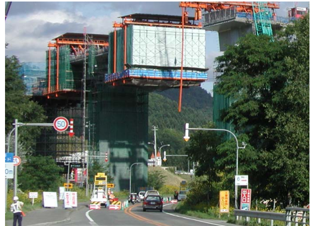
写真－3 国道交差部の施工状況
