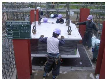
写真-3 支承設置・組立状況
