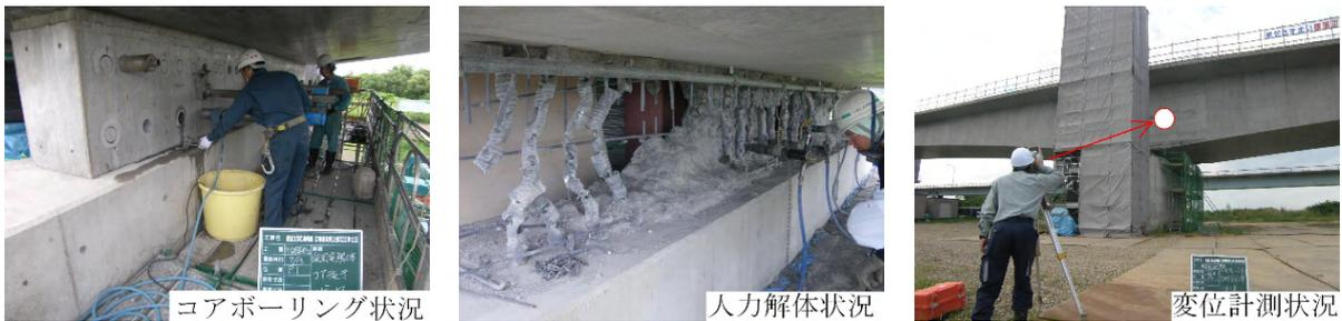
写真-4 仮支承解体・変位量計測状況
