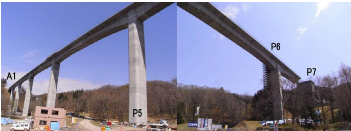
写真-2 全景 (平成23年5月現在)
