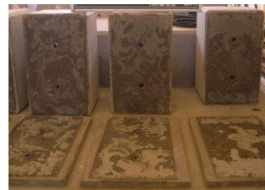
写真-2 破壊面の状況
