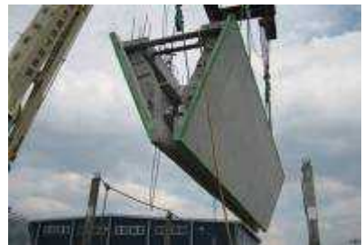
写真 - 5 部材吊込み状況
