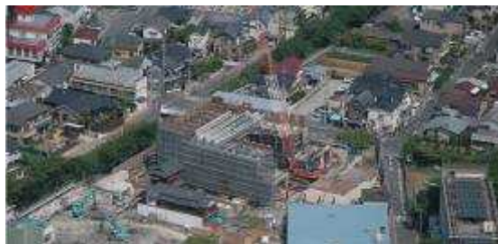
写真 - 7 建方状況
