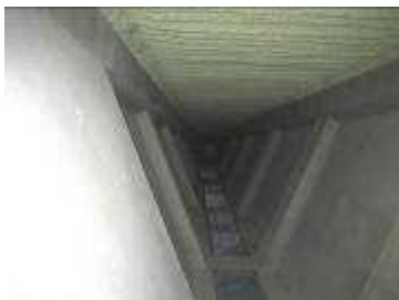
写真 - 6 PCa折板内側の状況
