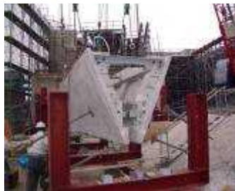
写真 - 4 現場地組状況
