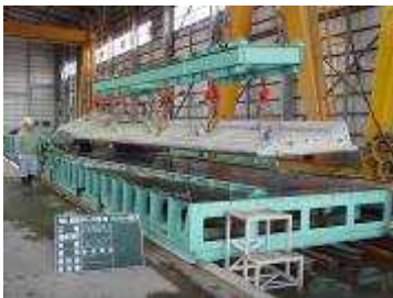
写真 - 3 部材脱枠状況
