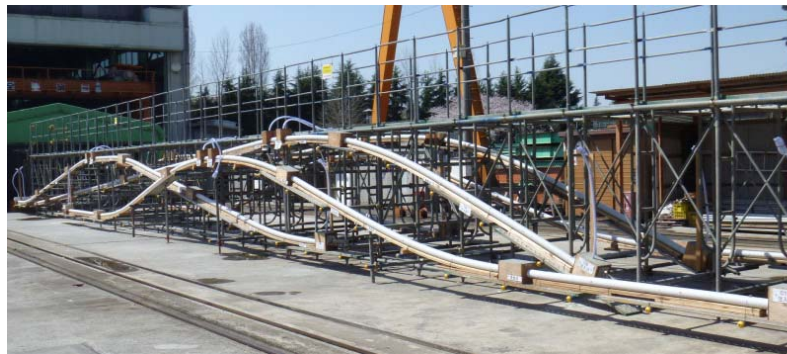
写真-1 試験体全景
