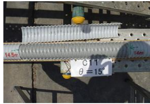
写真-3 下り勾配地点の充填状況
