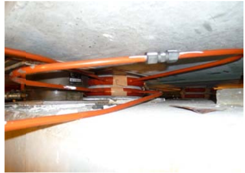
写真-4 2枚重ねた設置例
