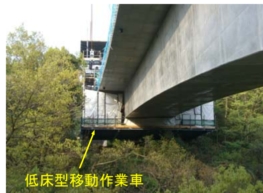
写真-4 片持ち架設状況
