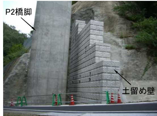
写真-2 土留め壁施工完了
