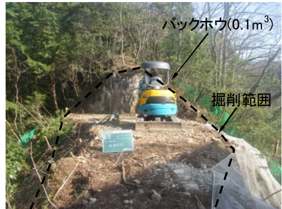
写真-5 尾根部掘削状況
