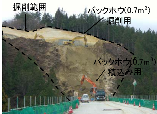
写真-6 A1橋台背面掘削状況
