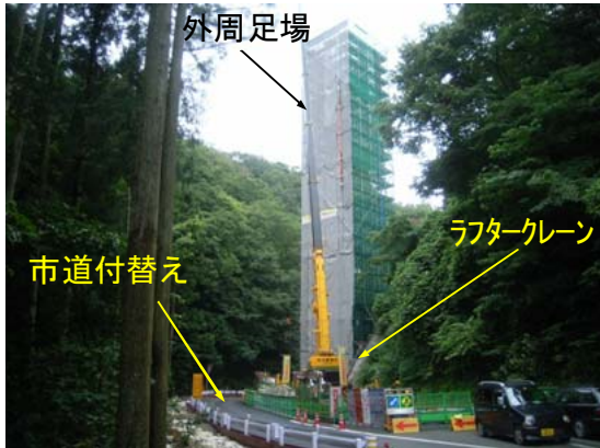
写真-1 橋脚の施工状況
