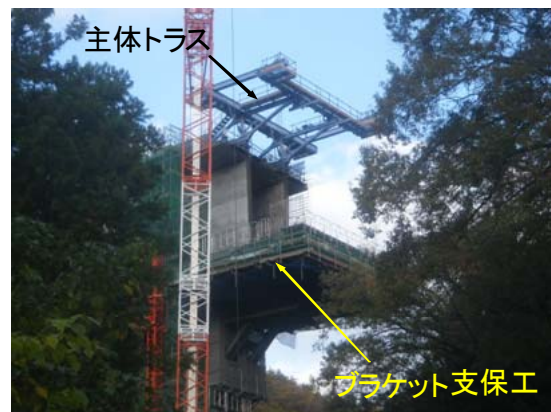
写真-3 移動作業車組立て状況 (P2)
