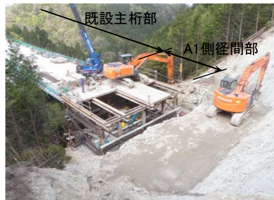
写真-7 A1橋台部掘削状況
