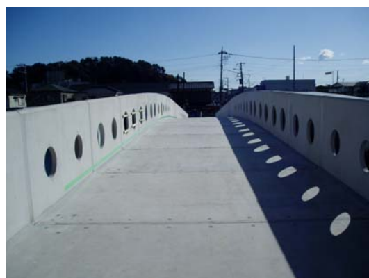
写真-9 主桁架設完了
