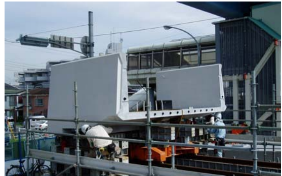
写真-1 主桁設置状況
