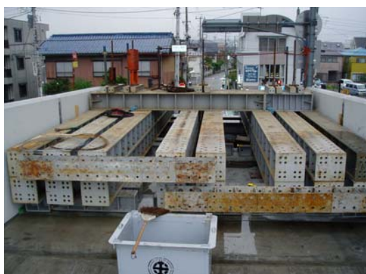
写真-8 梁材と主桁の固定状況
