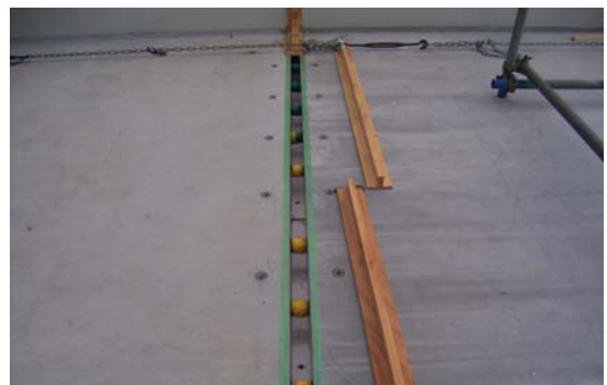
写真-3 床版上面セグメント継ぎ目部
