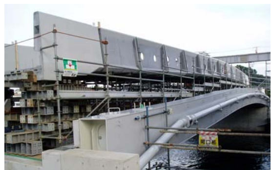
写真-5 主桁組み立て完了
