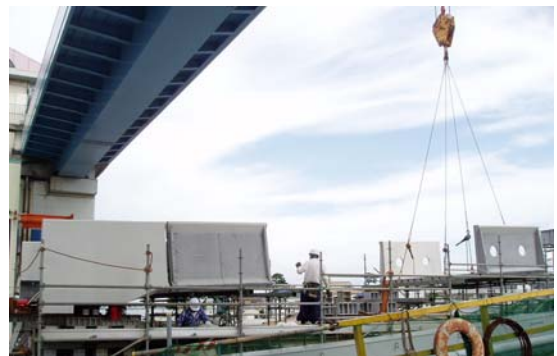
写真-2 主桁組み立て状況
